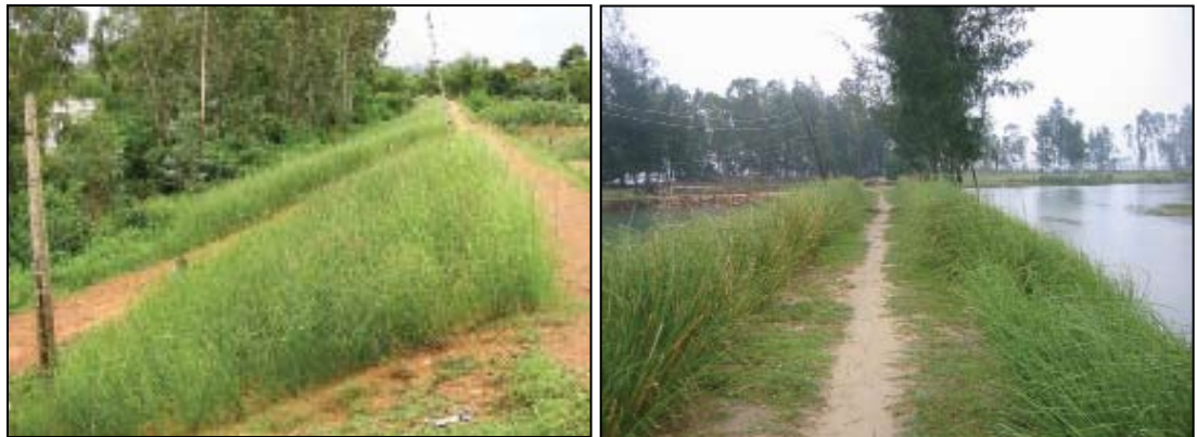
Foto 10: Izquierda: Vetiver y recubrimiento de roca (arriba) y placa de concreto (abajo) protegiendo un banco; derecha:
