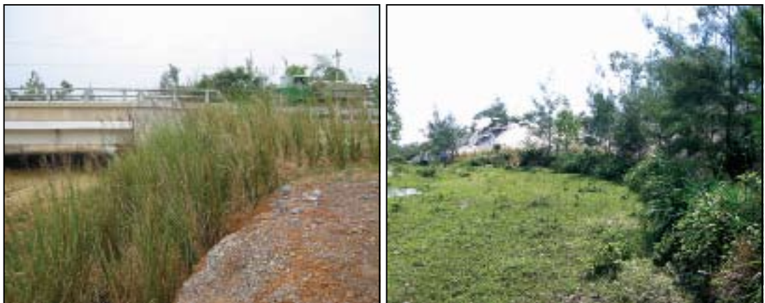
Foto 6: Izquierda: El vetiver protege las bases de un Puente en la Autopista Nacional Número 1; derecha: Diciembre 2004, las especies locales han remplazado el vetiver.
