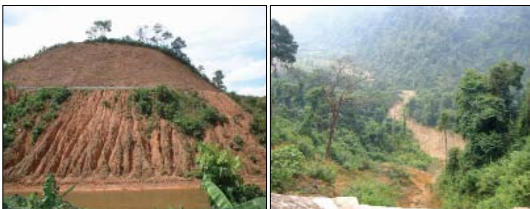
Foto 21: Da Deo Pass, Quang Binh: Izquierda: La cobertura de la vegetation ha sido destruída, revelando terribles y continuas fallas de taludes de corte cover; derecha: Hileras de vetiver sobre la parte superior de un talud que se mueve lentamente, redu-
