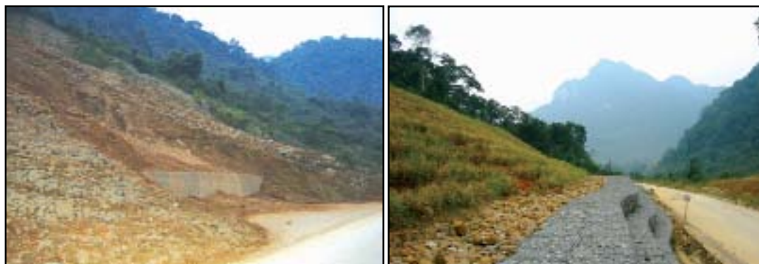
Foto 21: Da Deo Pass, Quang Binh: Izquierda: La cobertura de la vegetation ha sido destruída, revelando terribles y continuas fallas de taludes de corte cover; derecha: Hileras de vetiver sobre la parte superior de un talud que se mueve lentamente, redu-
