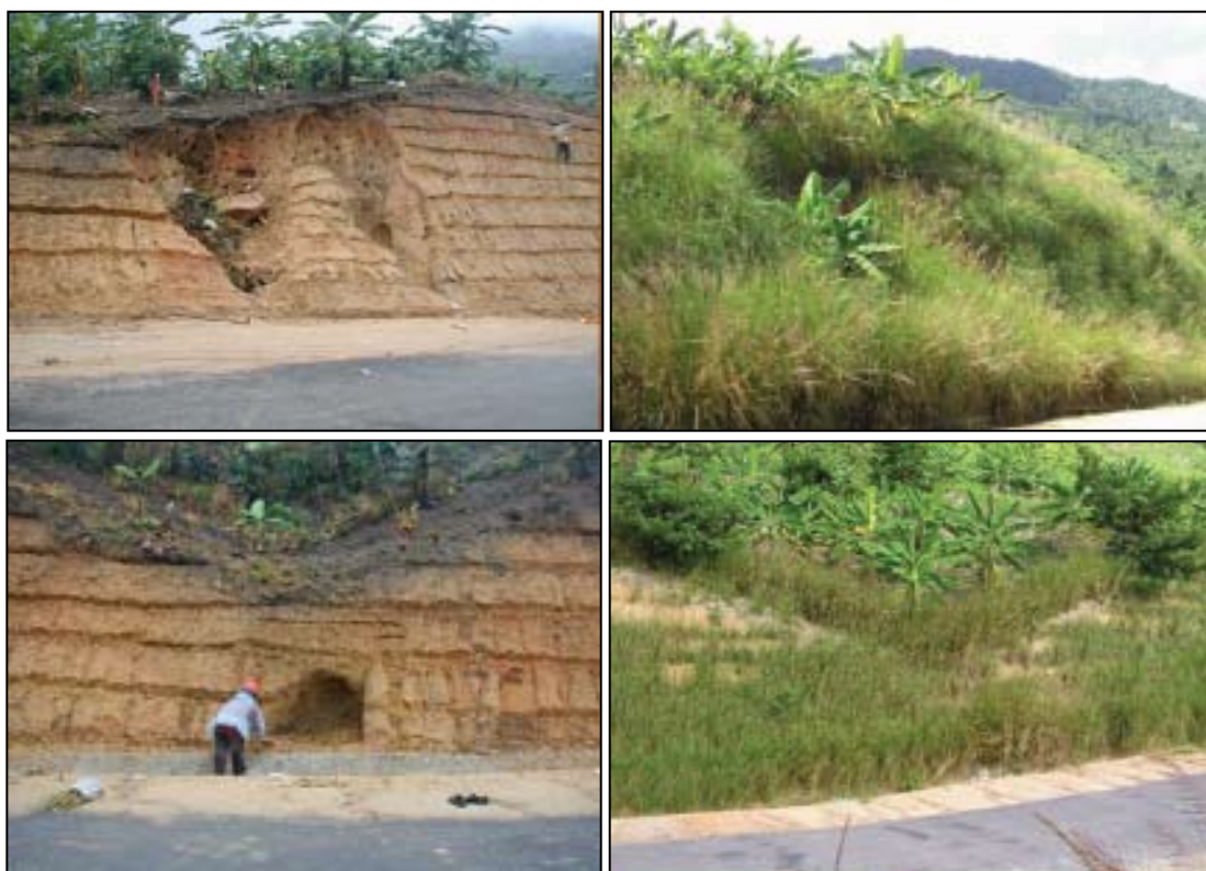
fotos de la izquierda: erosión severa en un talud recién construido que se presenta después de unas pocas lluvias; las dos fotos de la derecha: ocho meses después de sembrado el vetiver: el vetiver estabilizó este talud, previniendo y deteniendo completamente la erosión futura en la próxima estación lluviosa.
